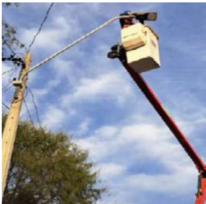
Adquisición e Instalación de luminarias Segunda Etapa
