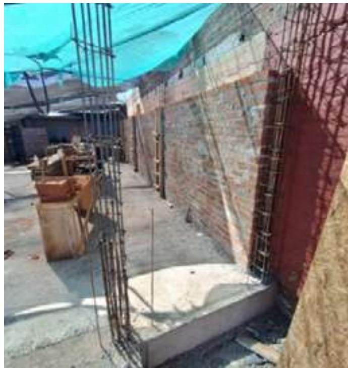
Construcción Sede Social U. V. N°6
